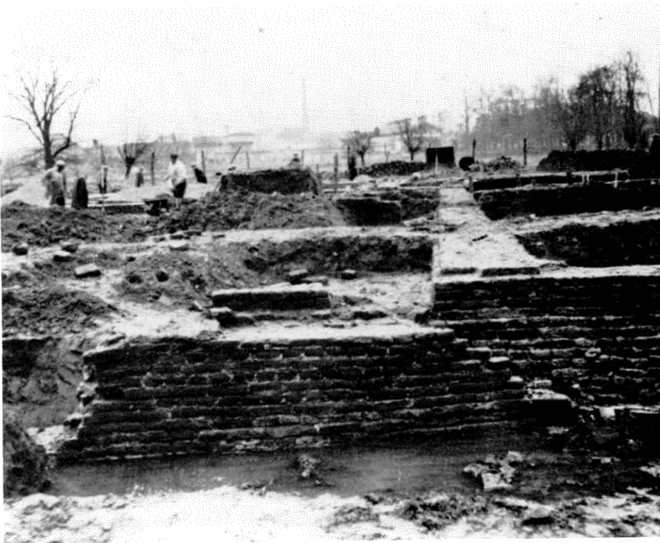
Afb. 5. Buitenzijde zuidmuur; aansluiting oudste buitenmuur en oostvleugel 2de periode.
