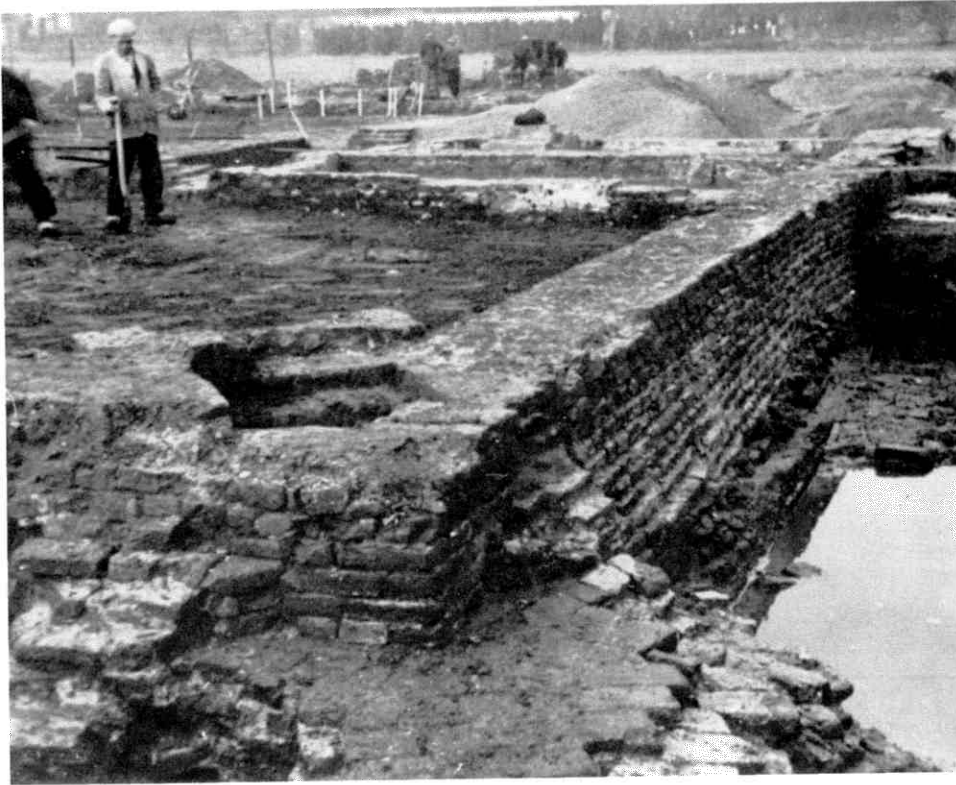
Afb. 4. Grunsfoort, fundamenten. Oosthoek gezien vanuit het oosten. Trapje naar de torenkamer, waarvan de vloer gedeeltelijk bewaard is. Opname 1937.
